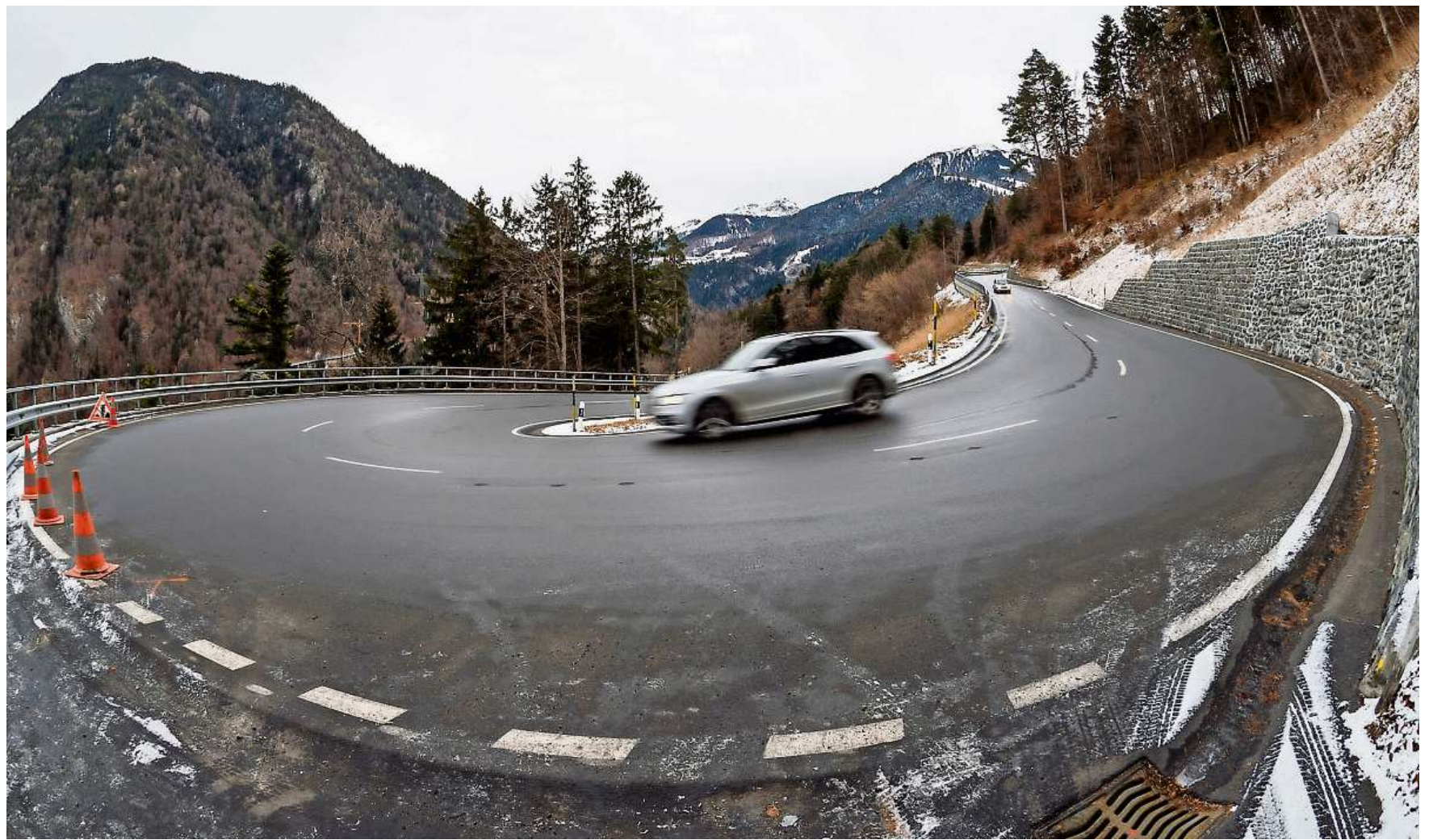
Auf ein Neues: In wenigen Monaten fahren bei der Gross-Kehr-Kurve oberhalb Chur wieder die Baumaschinen auf.
